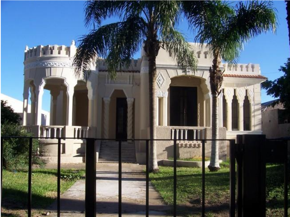
Sanatorio Saladillo: Casona con estilo Art Déco ubicada por calle Arijon a metros del Saladillo Club. Hoy en día la misma se utiliza como sanatorio del Sindicato de la Carne
